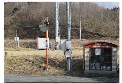
カーブミラーが設置されました(上羽根折沢地内)
